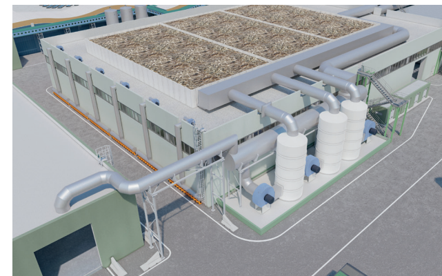
➤ Dettaglio biofiltro per trattamento arie esauste in copertura
