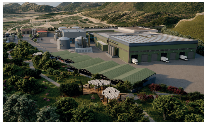
➤ Vista aerea dell'impianto
