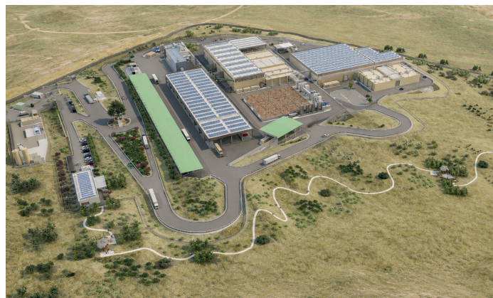
➤ Vista aerea dell'impianto
