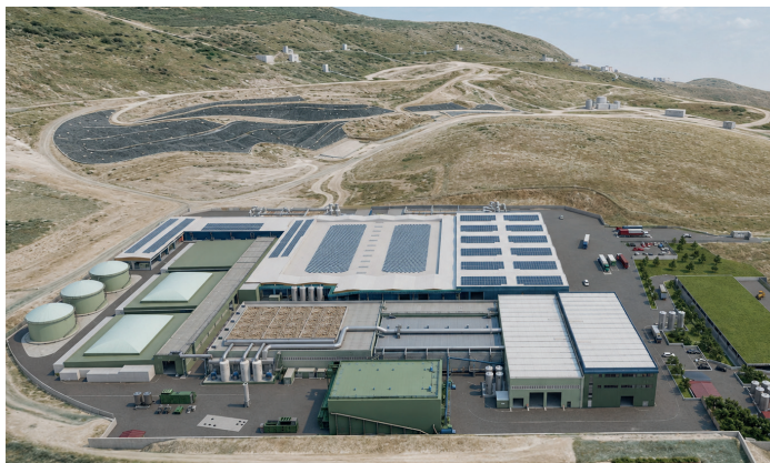
➤ Vista complessiva dell'impianto
