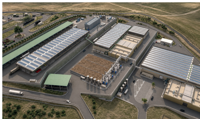
➤ Vista sezioni di trattamento dell'impianto
